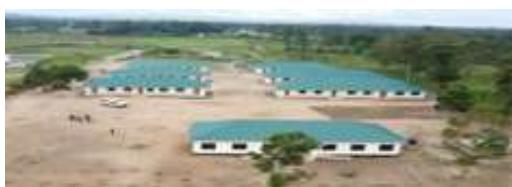
Ujenzi wa shule mpya Bunazi B
