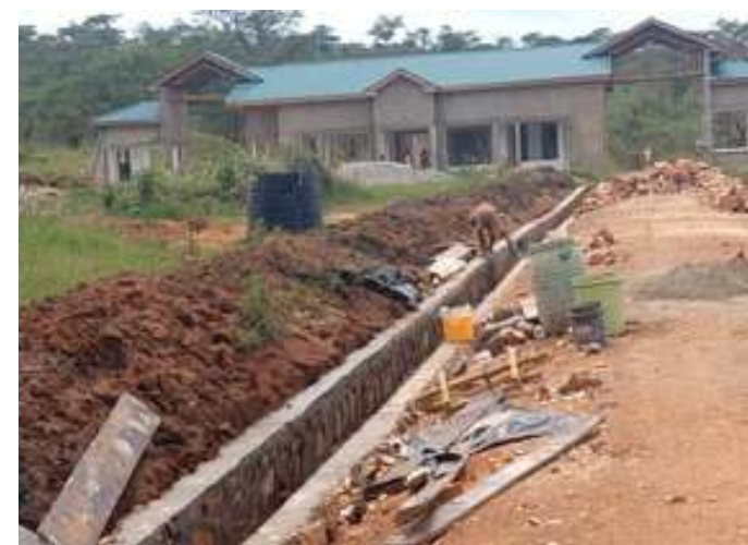
Ujenzi wa lango la watalii (Kifurusa Complex Gate)
