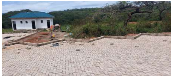
Eneo la maegesho ya magari wakati wa kutoka Hifadhini pamoja na choo katika mradi wa kifurusa complex gate
