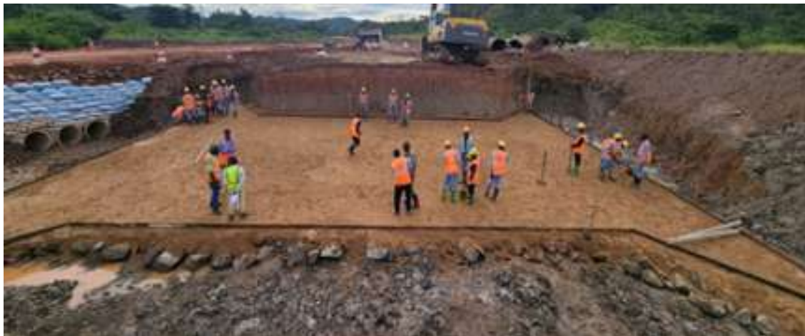
Ujenzi wa Daraja katika mradi wa ukarabati wa barabara ya Rusumo-Lusahunga km 92
