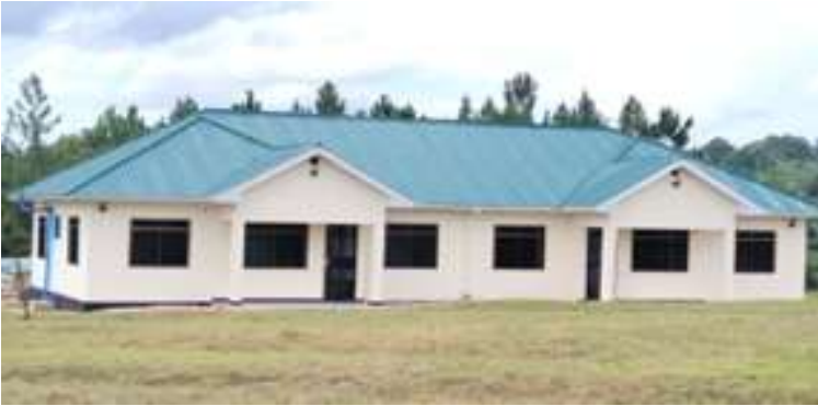
Ujenzi wa nyumba ya walimu Kitobo Sekondari
