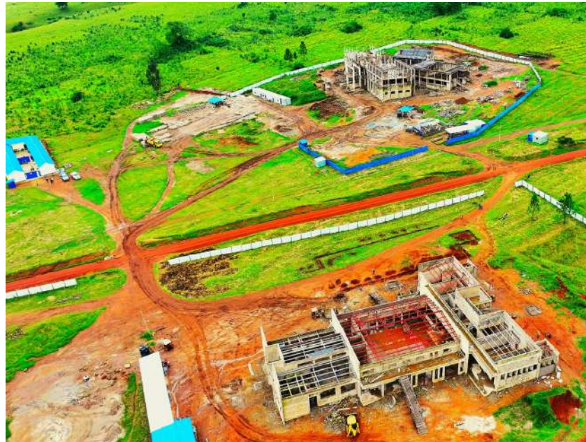
ujenzi wa kampasi ya udsu Bukoba ukiendelea
