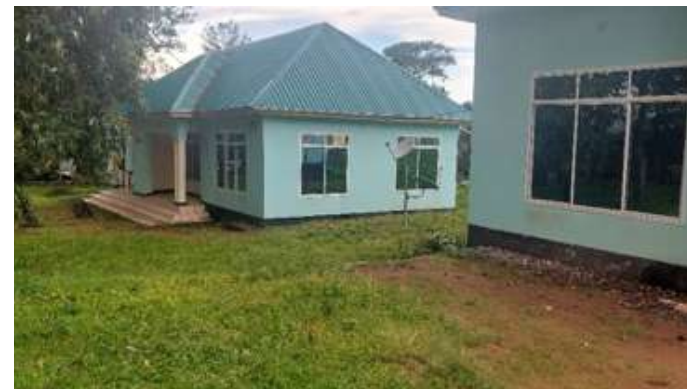
Nyumba za watumishi baada kufanyiwa ukarabati mkubwa (major rehabilitation)
